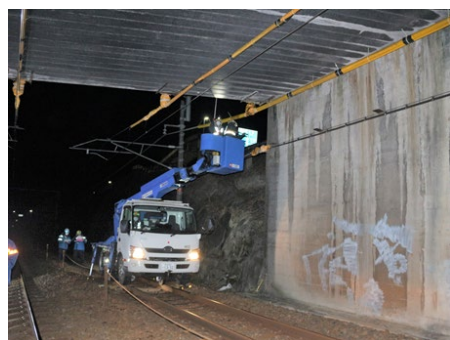
(a) 軌陸車を用いた点検
